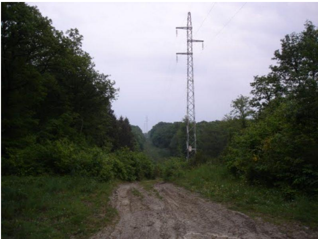
Etat initial avant travaux (le 2011-05-10)
