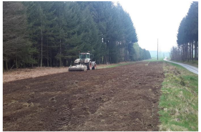
Action LIFE : travaux (le 2017-04-10)
