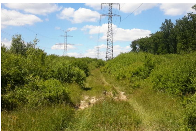
Etat initial avant travaux (le 2014-06-25)
