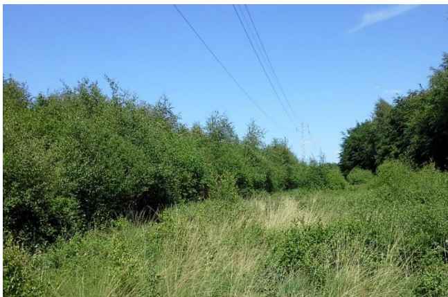
Etat initial avant travaux (le 2014-06-06)
