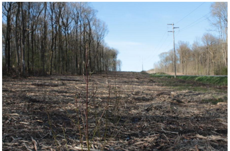
Action LIFE : travaux (le 2015-04-15)
