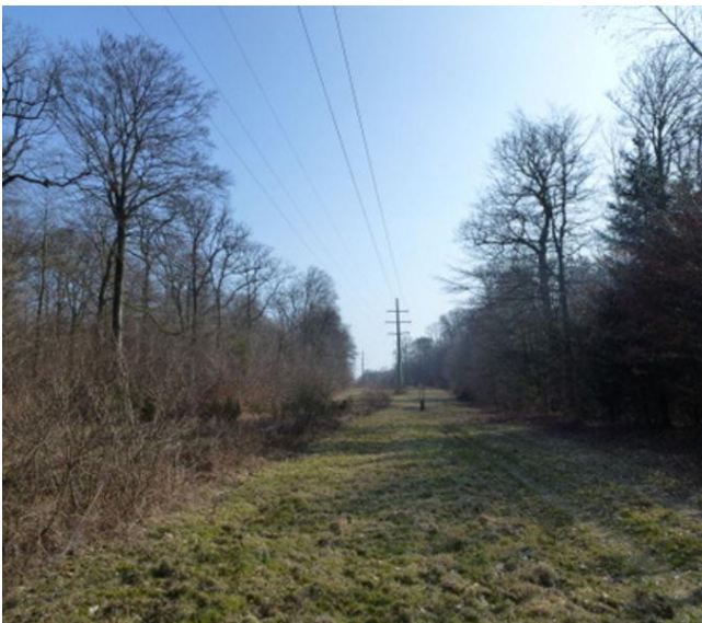
Etat initial avant travaux (le 2012-03-13)
