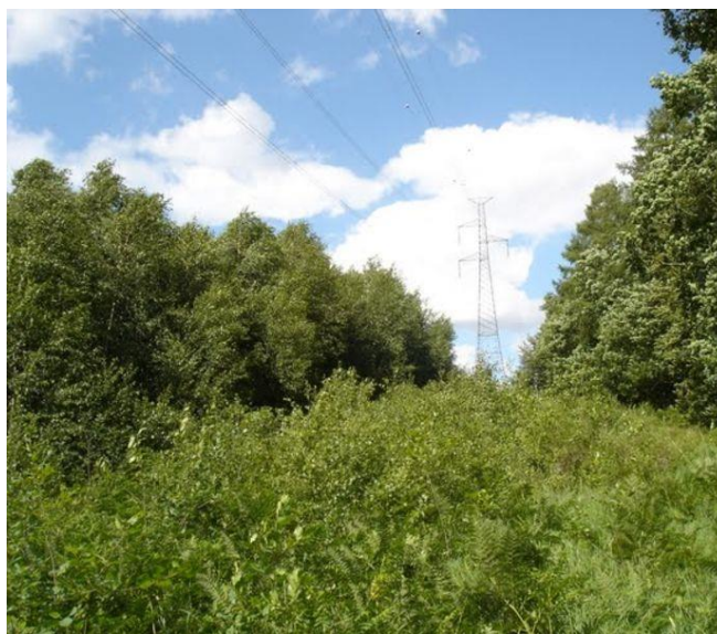
Etat initial avant travaux (le 2010-07-13)
