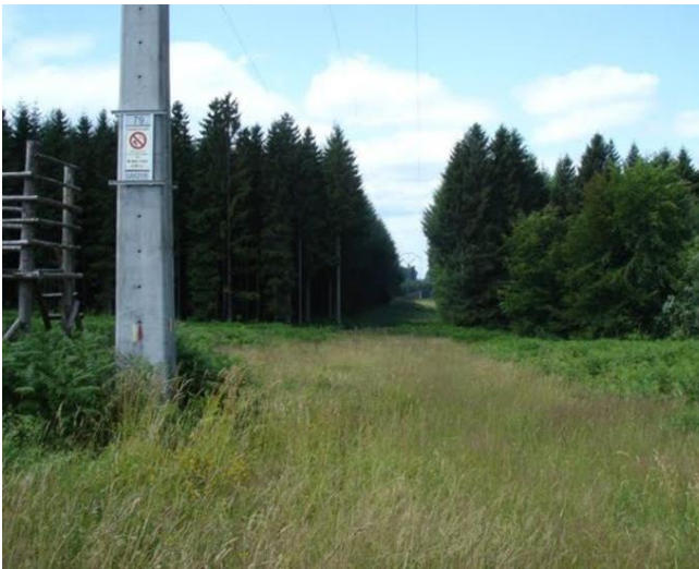
Etat initial avant travaux (le 2010-07-16)
