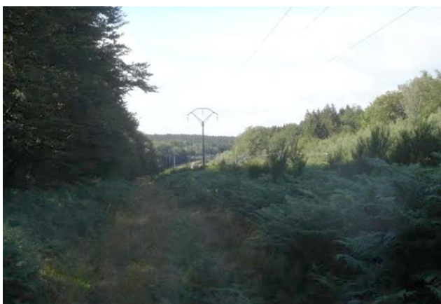
Etat initial avant travaux (le 2011-08-05)
