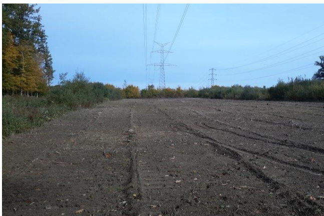
Action LIFE : travaux (le 2015-10-12)
