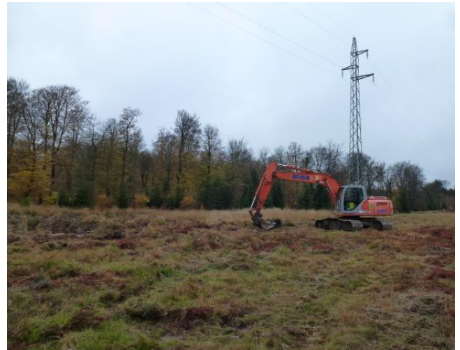
Action LIFE : travaux (le 2013-11-07)
