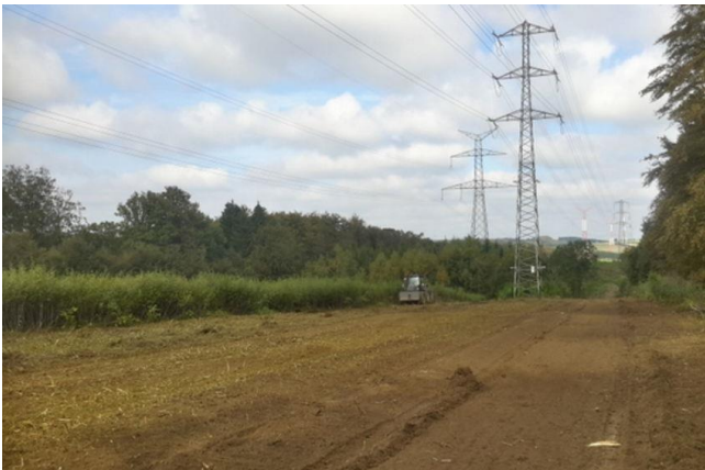
Action LIFE : travaux (le 2014-09-15)
