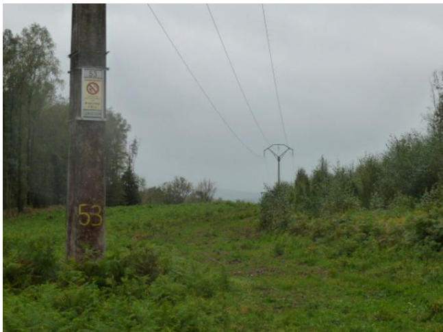
Etat initial avant travaux (le 2012-10-05)
