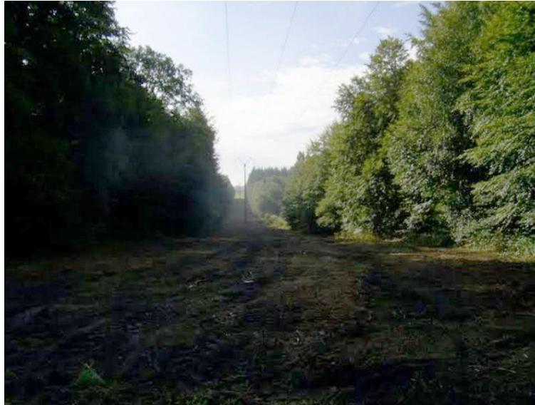
Etat initial avant travaux (vers 2012-2013)
