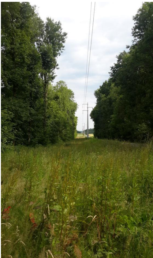
Etat initial avant travaux (le 2014-07-04)
