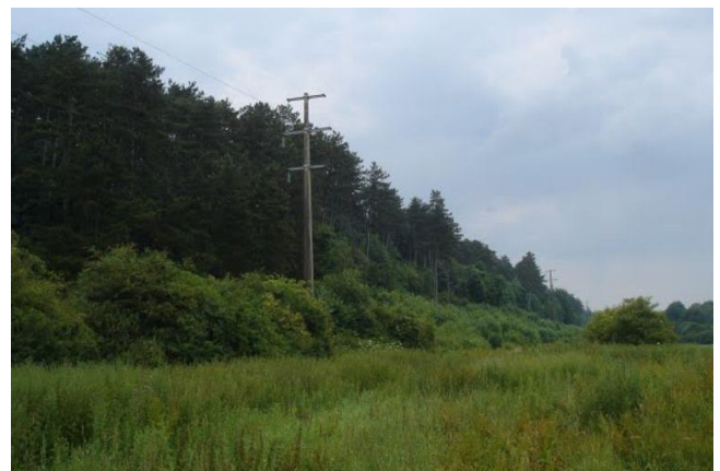
Etat initial avant travaux (le 2008-07-02) pour la ligne 70.154
