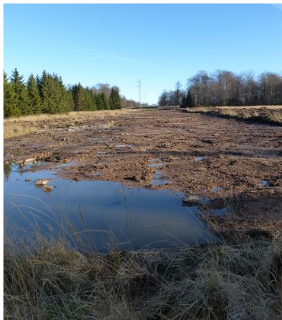
Action LIFE : travaux (le 2013-12-10)
