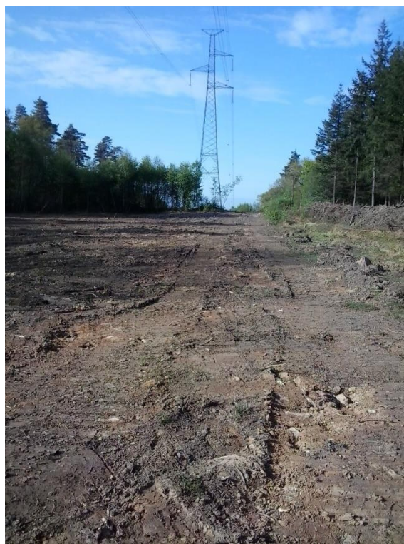
Action LIFE : travaux (le 2014-04-22)
