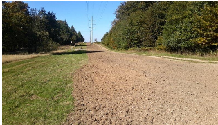
Action LIFE : travaux (le 2015-10-01)
