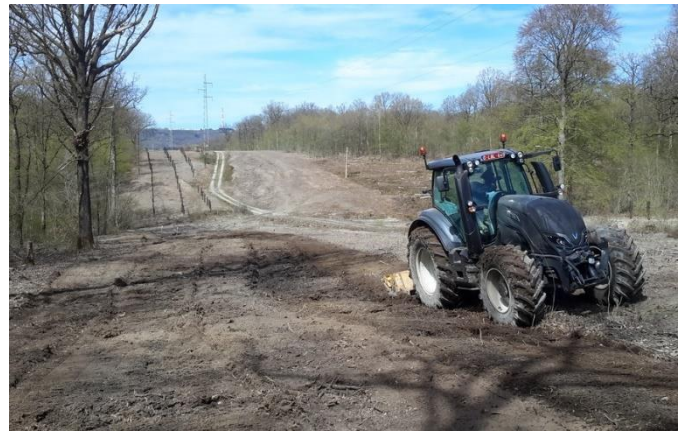
Action LIFE : travaux (le 2016-04-21)
