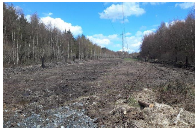
Action LIFE : travaux (le 2016-04-15)
