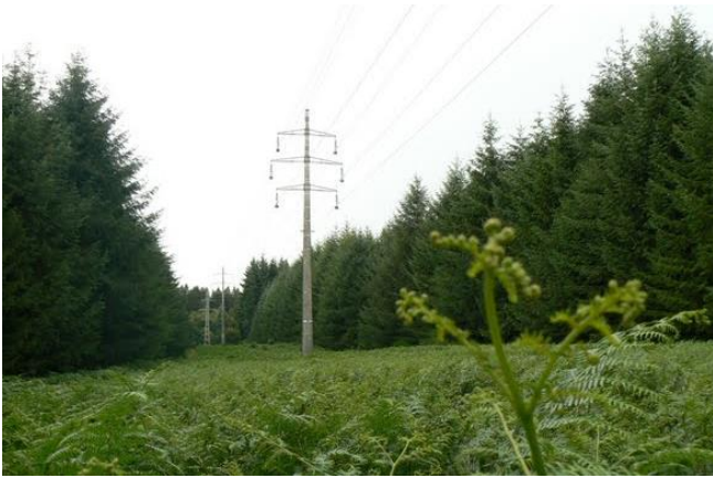
Etat initial avant travaux (le 2009-07-27)
